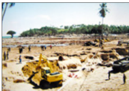
El equipo para el movimiento de tierra donado contribuye a los esfuerzos de reconstrucción en Indonesia.
