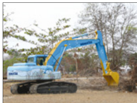
Las excavadoras hidráulicas con el tema de la naturaleza, simbólico del espíritu de dar y de conservar el ambiente de BMW y del Grupo Komatsu, ya se encuentran en uso para los esfuerzos de reconstrucción en Tailandia.
