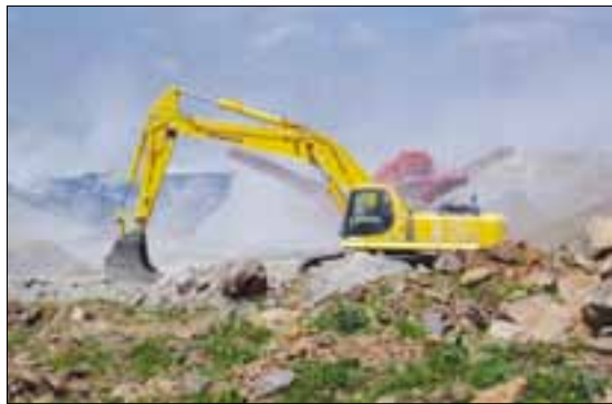
Se utiliza un modelo Dantotsu PC450-7 para excavar y alimentar una trituradora móvil BR350JG en la operación de agregados.
