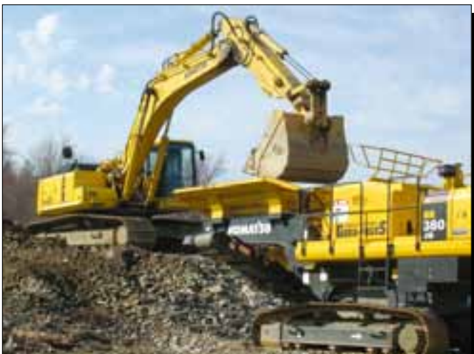
Una excavadora hidráulica Komatsu PC300LC carga roca de granito en la trituradora móvil BR380JG-1 para la trituración.
