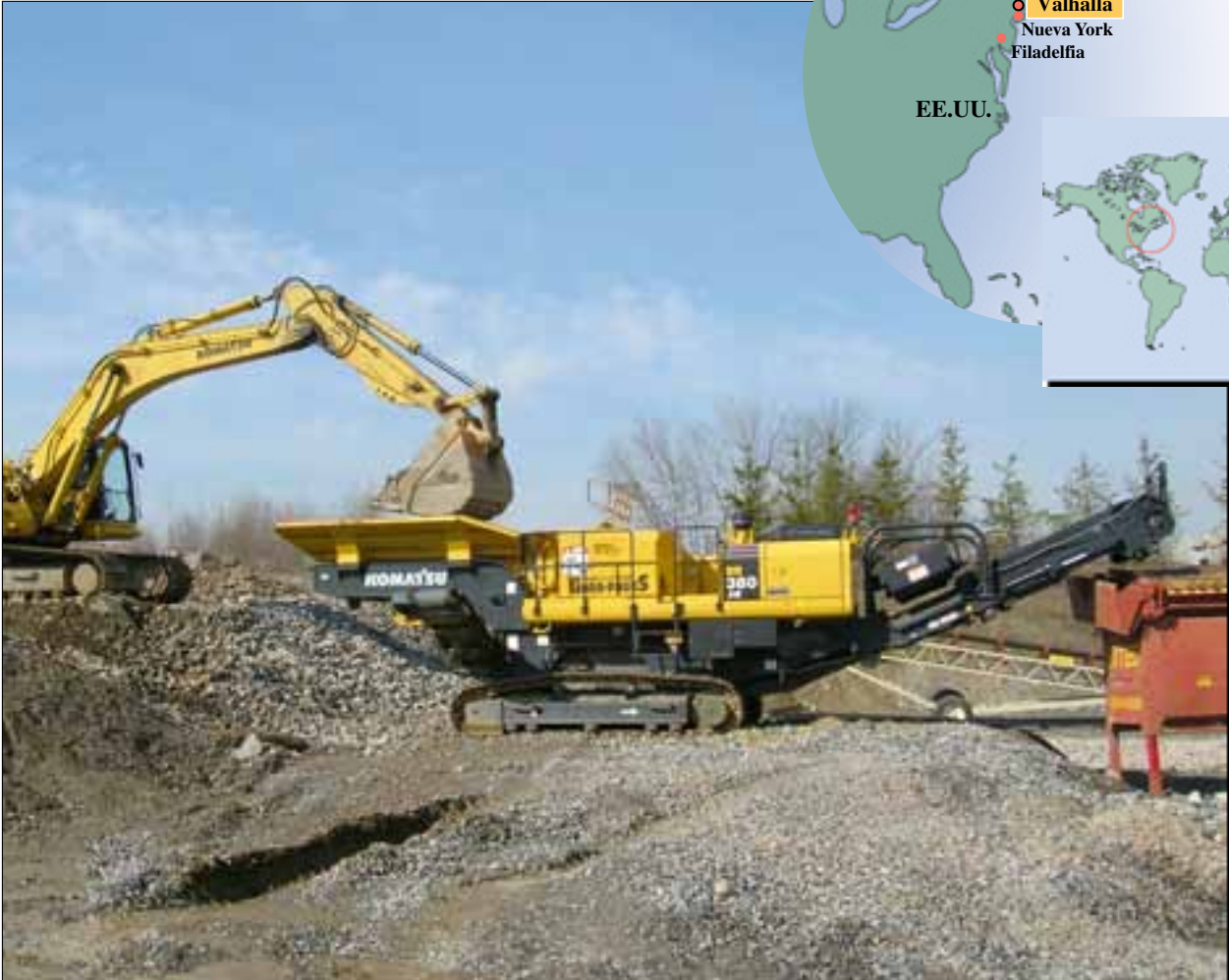
La trituradora móvil Komatsu BR380JG-1 le ayuda a AKR Excavating Inc. a reciclar la roca que excava, así como también sus escombros de demolición.
