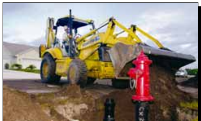
Felix Associates, LLC usa el cucharón versátil en la WB140-2 para rellenar alrededor de las bocas de incendio.
