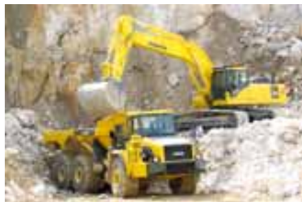
Trabajando con ahínco, una excavadora hidráulica PC450LC-7 equipada con una pluma corta y un camión volquete HM400-1 se demostraron por primera vez en el Reino Unido.
