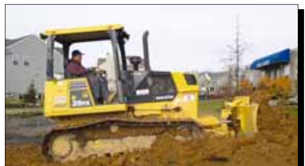
Segal & Morel utiliza su tractor KOMSTAT II para la cobertura con tierra vegetal, para la nivelación inicial, para el trabajo de fundaciones y para el relleno alrededor de las canalizaciones públicas.
