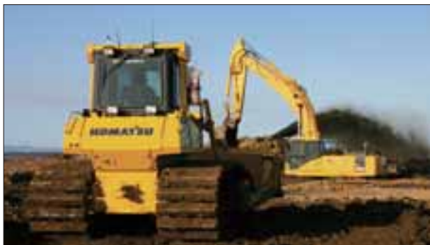
El equipo Komatsu utilizado en el proceso de recuperación para ampliar las instalaciones portuarias
