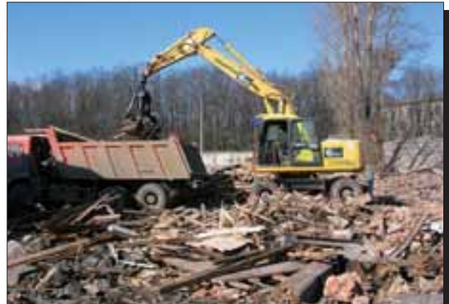
La PW170ES-6K limpia los escombros.
