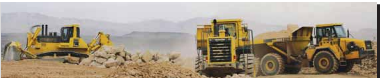
Parte de la flota Komatsu de Gilbert Development trabaja junta en un proyecto de urbanización de tierras cerca de St. George.
