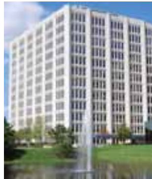
La nueva sede central de Komatsu America Corp. en Rolling Meadows, Illinois
