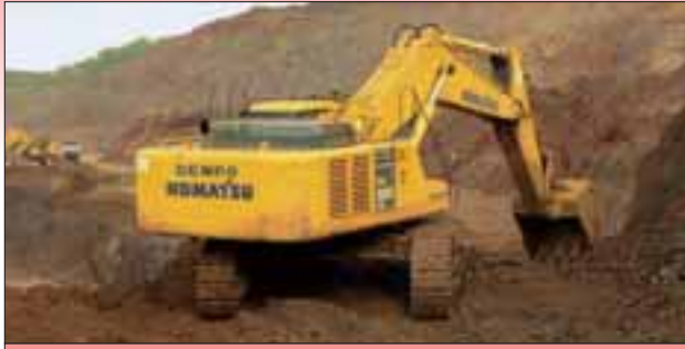
La excavadora hidráulica PC600LC trabajando en la mina de Bicholim de Dempo
