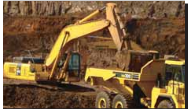
Una excavadora hidráulica PC400LC carga un camión volquete articulado HM300 en la mina de Salgaocar, la primera mina en la India en usar este modelo Komatsu.
