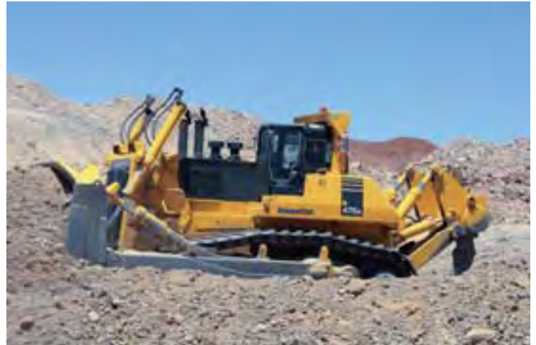
Un tractor sobre orugas D475A acopia grava diamantífera aluvial para la excavadora hidráulica PC800SE, que carga el material en camiones volquete articulados HM400.
