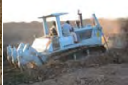
Los operadores de Water Works Construction Enterprise verifican el funcionamiento de la máquina.
