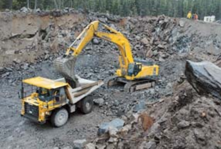
Un operador de Johnson's Construction usa una excavadora hidráulica Komatsu PC800LC de 363 kW (487 HP) para cargar un camión volquete rígido HD325 de 36 toneladas (40 toneladas americanas).
