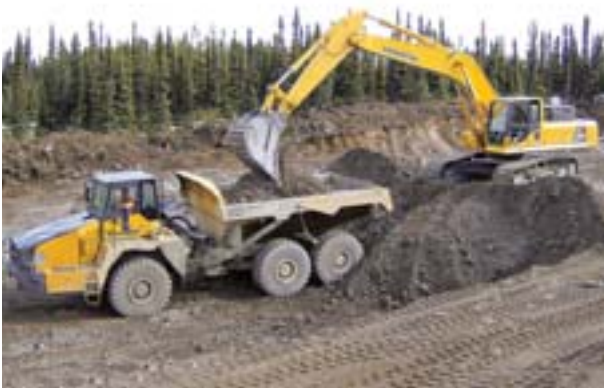
Aproximadamente 60 equipos Komatsu están trabajando en el Labrador, y entre los mismos se incluyen excavadoras hidráulicas PC400LC y camiones volquete articulados HM350.
