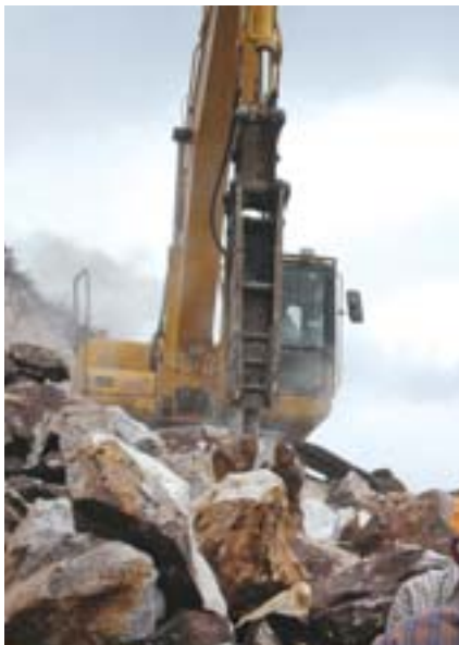
La excavadora hidráulica PC200 equipada con un accesorio triturador de rocas en operación
