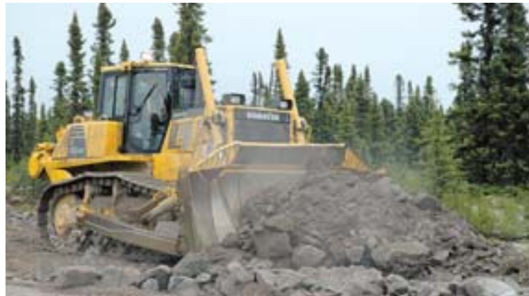
El tractor de orugas Komatsu D155 esparce material en una sección de la Autopista Trans-Labrador que Johnson's Construction está mejorando
